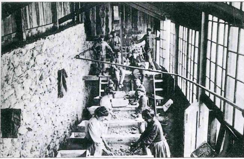
Ci-dessus et ci-contre, les différentes opérations de tri, lavage et traitement du minéral sur le site de la Minière de Vallauria. Collection Armand OLIVIERO
