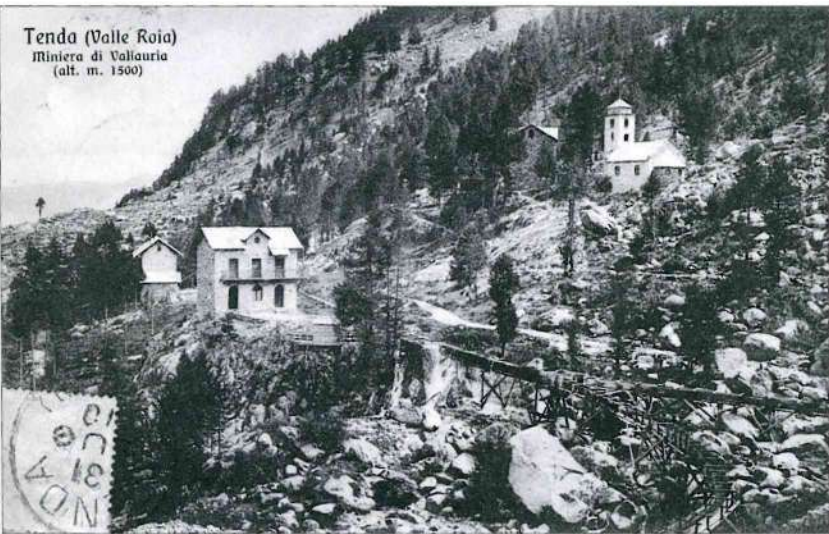
Ci-dessous, deux vues de la Minière de Vallauria vers 1910. En bas de page, le sentier muletier entre les Mesce et la Minière. Collection Armand OLIVIERO
