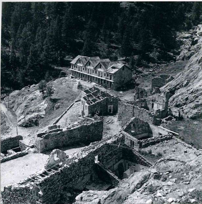
Ci-dessus, les bâtiments de la Minière en 1957. En bas, les premiers chantiers de 1961.
