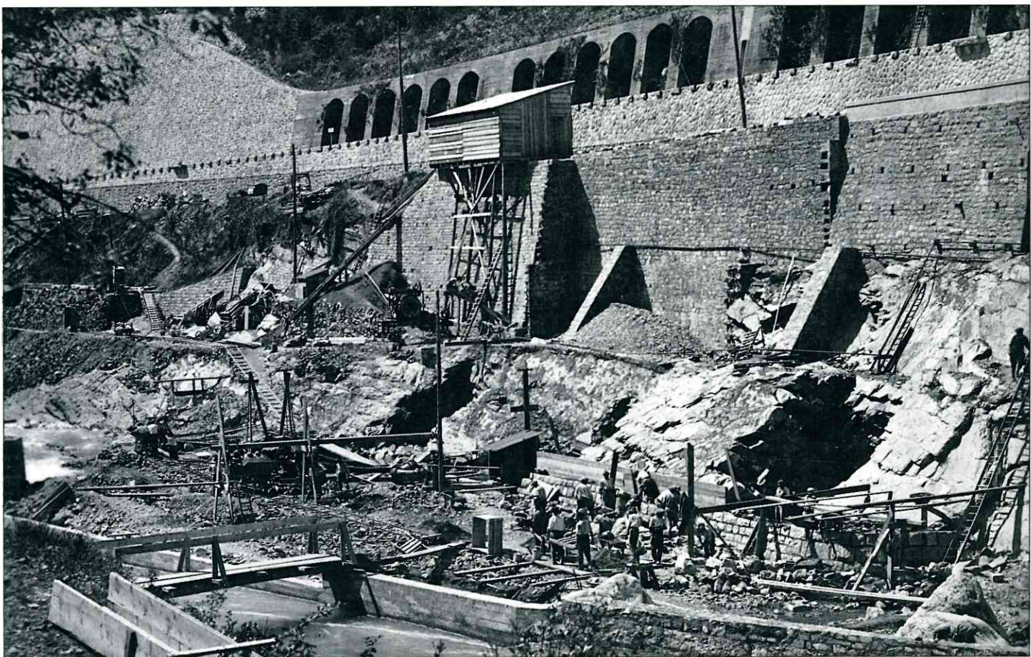
3672. FONTAN (A.-M.) - Usine Electrique Vallée de la Roya
