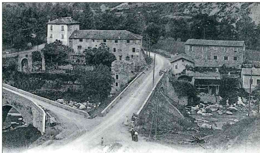
Une usine électrique fut installée dès 1903 au quartier Ambo, à Saorge. Il s'agit probablement du petit bâtiment situé à l'extrême droite de ce cliché. Collection Jean-Pierre GARACIO
