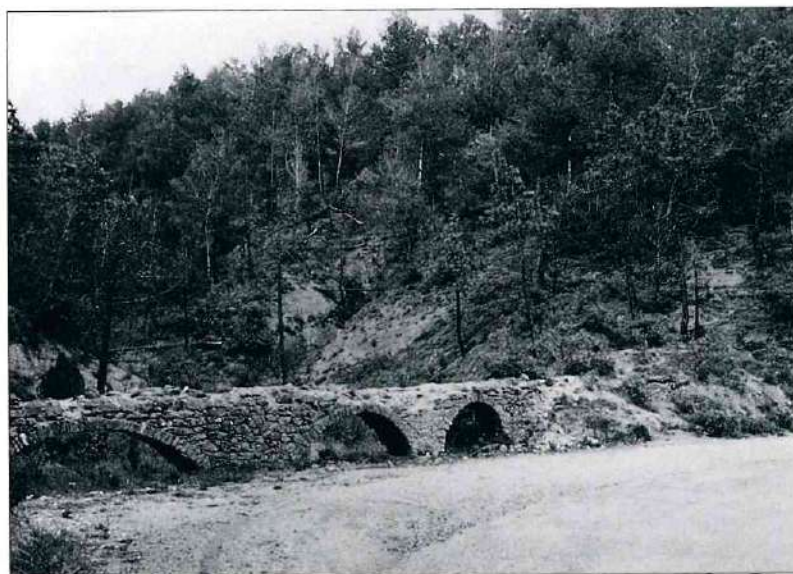
Le pont à quatre arches (trois visibles sur la vue) portant le tuyau qui s'enfonce dans la terre pour remonter la pente (à droite sur la vue).
