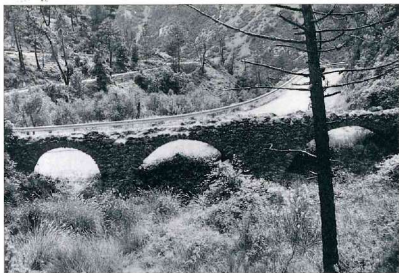
Le pont vu du côté du vallon.
