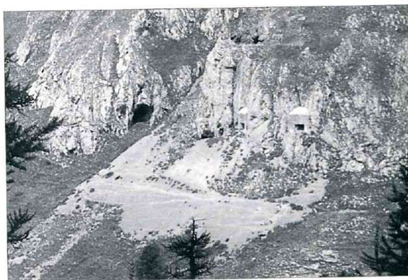
Ouvrage de Rocca Cuna «Ouest» : les deux blocs 1 et 2 encastrés dans la falaise.
