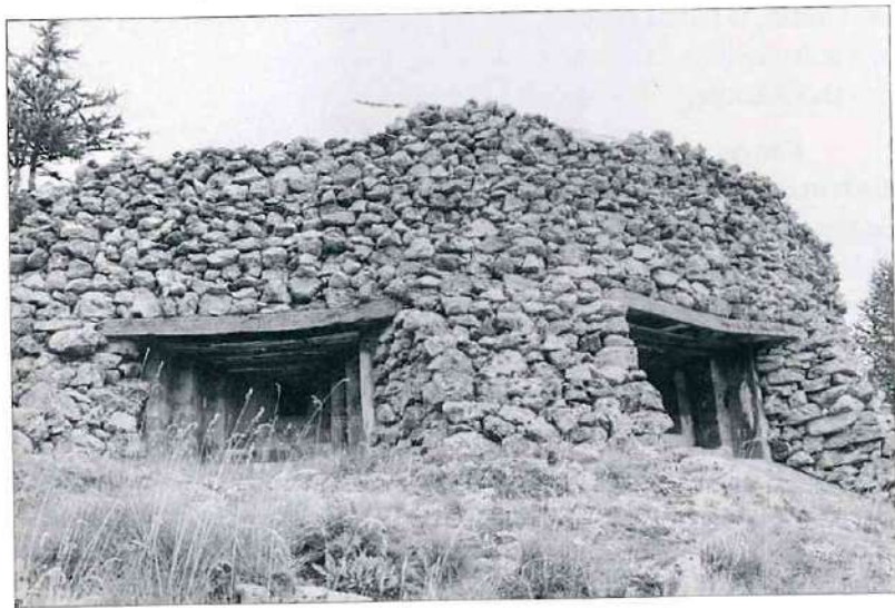
Ouvrage de Rocca Cuna «Centre», bloc 2. Camouflage par revêtement de pierraille.
