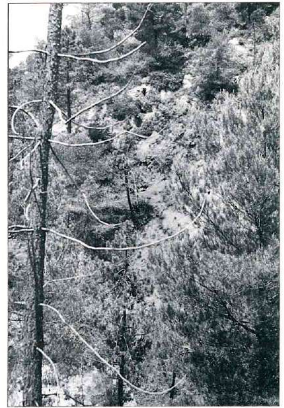
Pente à 60° où descend de la construction, que l'on distingue en haut sur la vue, un tuyau recouvert de pierres cimentées.
