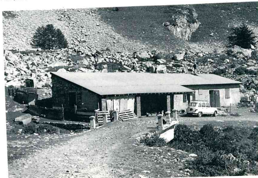
La bergerie du pont de Peirafica, à proximité de laquelle se trouve une source où l'on peut se désaltérer. Photo José BANAUDO
